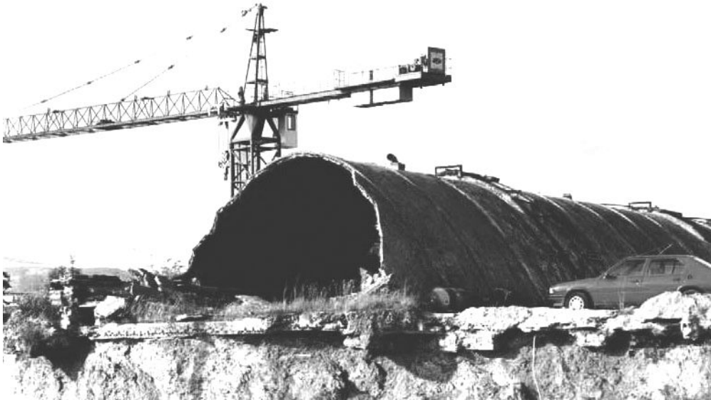
Figura 6.3. Nave de la empresa Rubiera, en Gijón: bóveda tabicada de cañón reforzada con arcos fajones. Construida hacia 1950. (Martín 2003, 75)
