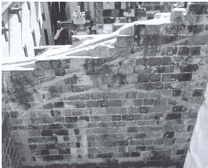
Figura 1.13: Huella de bóveda tabicada y del tejado superior, también de rasillas, en la capilla real de la catedral de Barcelona, mandado construir por el rey Martín I el Humano, en 1407 (Conejo 2012, 113).
