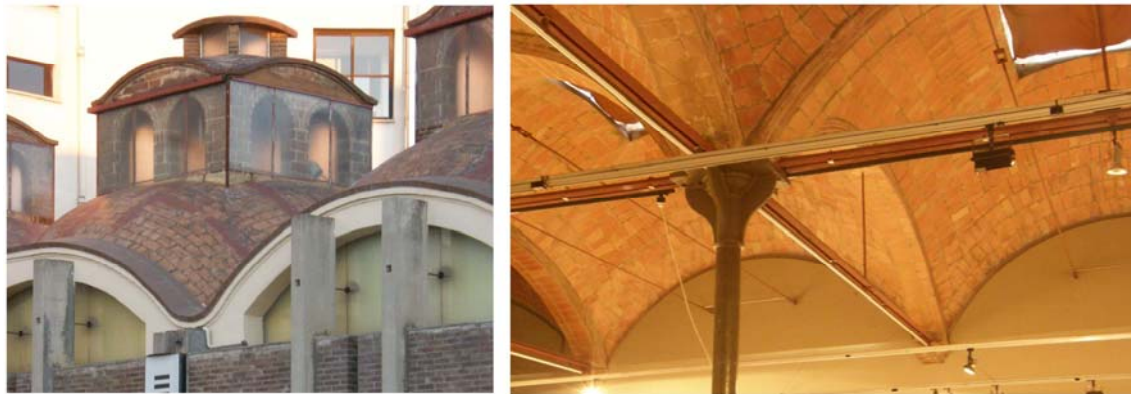
Figura 6.20: Vapor Amat. A la izquierda, detalle del exterior de las bóvedas. A la derecha, vista interior. Fotografías tomadas en enero de 2013.
