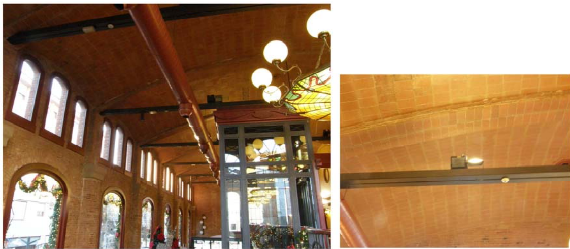
Figura 6.18: A la izquierda, interior de la Fábrica de Electricidad de Tarrasa. A la derecha, detalle del arco y de su atirantamiento. Detrás se ve la bóveda, sin atirantar. Imágenes de enero de 2013.
