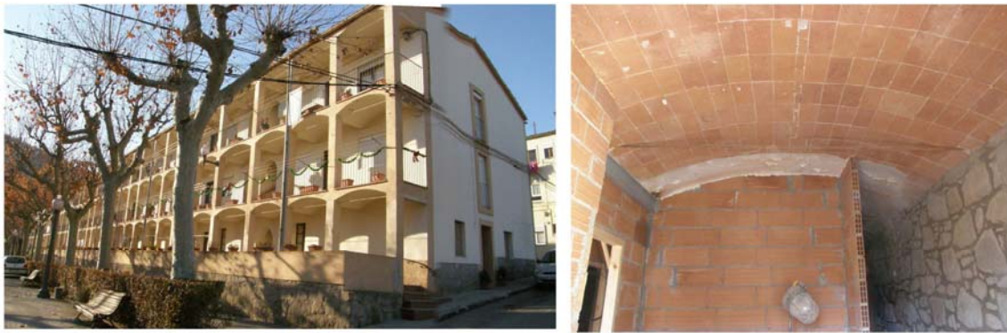
6.35. Colonia Viladomiu Nou (Gironella, Barcelona), vista del exterior. A la derecha, Interior de una de las viviendas, con bóveda tabicada atirantada. Imágenes tomadas en enero de 2013.
