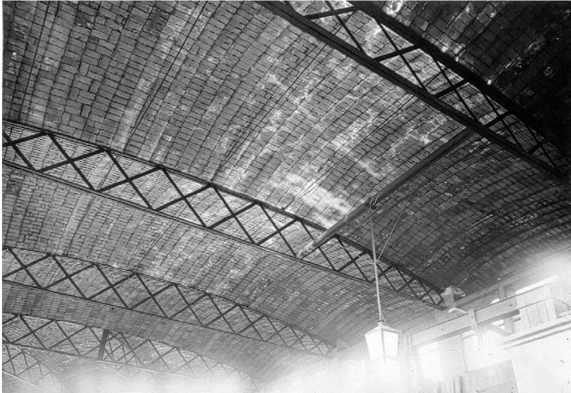
Figura 5.20: Naves de la empresa Can Torras, en Poblenou (Barcelona), anteriores a 1910. Vigas en celosía y bóvedas tabicadas sobre ellas. El sistema constructivo se describe en Martorell (1910, 127): «Bóvedas.- Generatriz y directriz circular. Dimensiones 5,65x14 m. Bóveda simple de dos gruesos de rasilla y otro de ladrillo (8 cm.). Flecha 0,50 m. Tirantes.-Hierros de 22 mm. de diámetro, separados 2,10 m», de donde también se ha extraído la imagen
