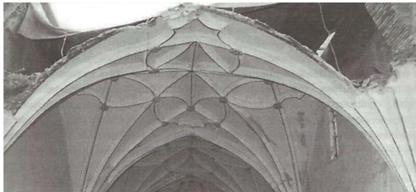
Figura 1.23: Bóveda tabicada en la iglesia de Los Fayos (Zaragoza), con las bóvedas tabicada de ladrillo y los nervios decorativos de yeso. (Ibáñez 2005, 105)
