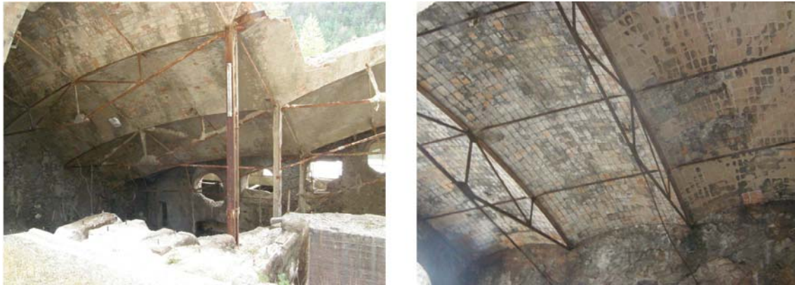
6.24. Edificios en ruinas o parcialmente restaurados dentro del conjunto de la fábrica Asland. Imágenes de enero de 2013.
