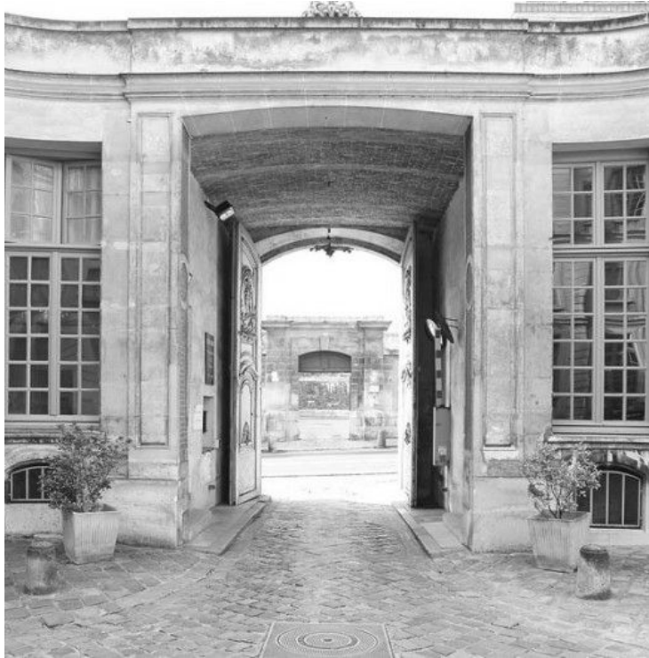
Figura 3.4: Imagen actual de una bóveda tabicada en la entrada del Ministerio de la Guerra, en Versailles (Original en fr.topic-topos.com/livres/versailles )
