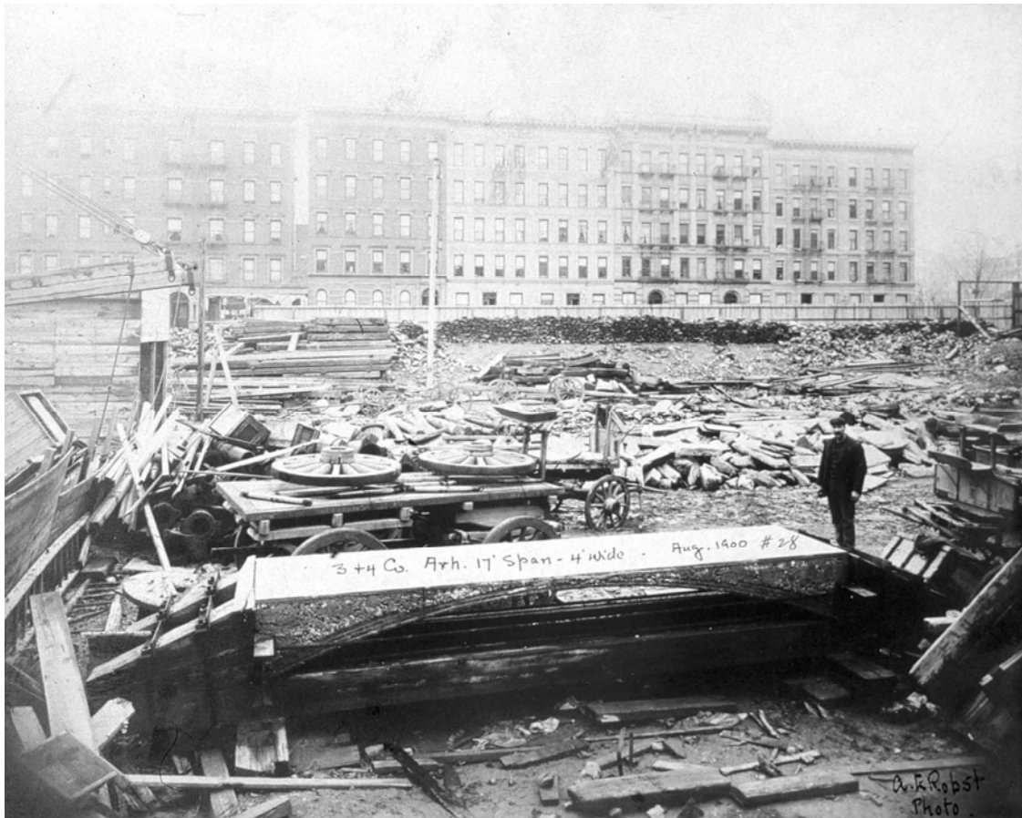
Figura 8.35: Fotografía de una bóveda para ensayar antes de cargarla. Tiene 17 pies (5,20 m) de luz y 4 (1,22 m) de ancho, la fotografía es de agosto 1900. Debajo hay una robusta estructura de madera y acero para resistir los empujes (Archivo Guastavino/Collins. U. Columbia).
