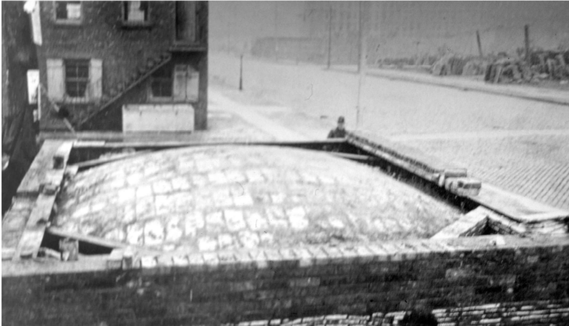
Figura 8.30: La bóveda terminada, preparada para recibir el relleno. 3 marzo 1897. En el informe, photograph n° 1236 . (Archivo Guastavino/Collins. U. Columbia).
