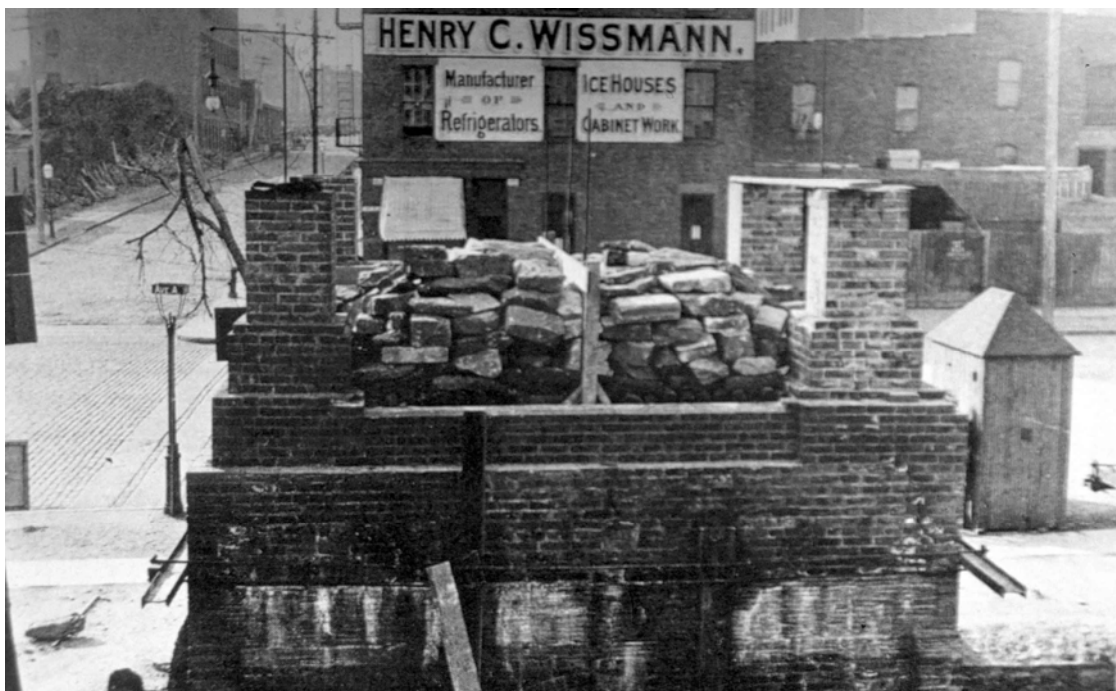
Figura 8.34: Bóveda cargada con 25 KN/m 2 , después del fuego. 3 abril 1897. En el informe, photograph n° 1267 . (Archivo Guastavino/Collins. U. Columbia)
