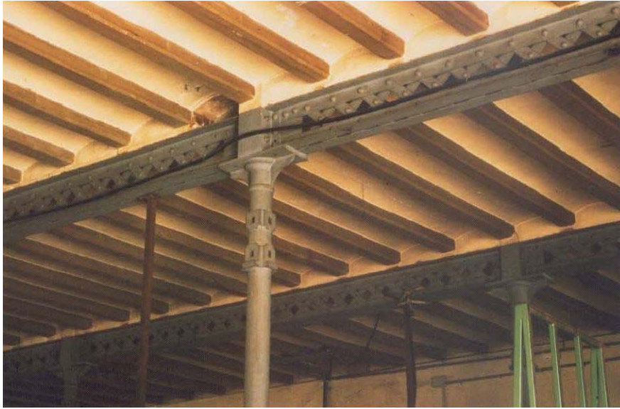
Figura 6.4: Forjado con vigas y columnas de hierro y forjado de madera, en Ca l'Abadal . Entre las vigas hay revoltones de ladrillo (Gumá 1996, 254)
