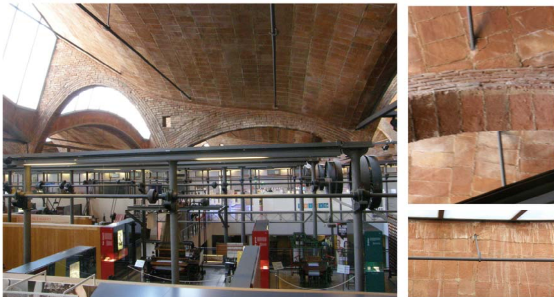
Figura 6.16: Vapor Aymerich, Amat y Jover. A la izquierda, vista general del interior. A la derecha, detalles de la unión ladrillo-tirante y ladrillo-sistema de cuelgue. Ambas imágenes son de estado actual (enero 2013).
