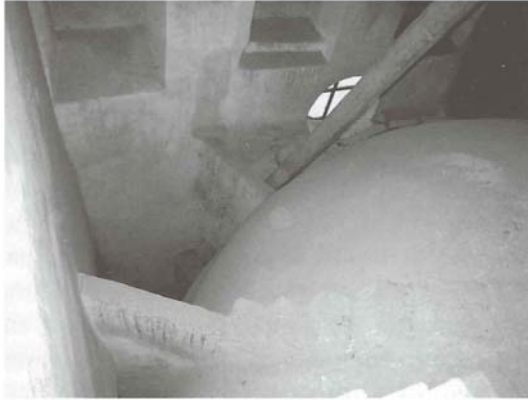
Figura 1.25. Cartuja de Granada, cúpula tabicada en la sacristía. A la izquierda, fotografía del trasdós con las lengüetas que unen cúpula y muros laterales. A la derecha, sección, en la que se aprecia que la cúpula es de doble hoja (Almagro 2012, 53)
