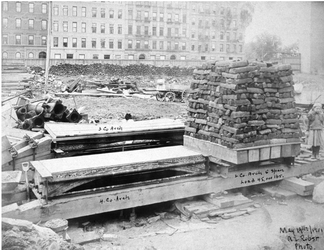
Figura 8.36: Fotografía de varias bóvedas de distinto tamaño, antes y después de ser cargadas, fotografía de mayo 1901. Descansan en perfiles de acero en doble T fuertemente atirantados. Bajo la bóveda cargada se indica que tiene 6 pies (1,83m) de ancho y que se le ha aplicado una carga de 45000 libras, unos 204,00 kN. (Archivo Guastavino/Collins. U. Columbia)
