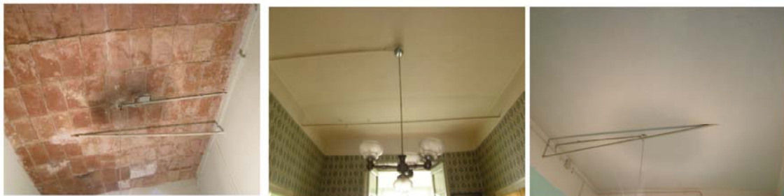
6.34. Colonia Marsal (Puig Reig, Barcelona). Interior de las viviendas, cubiertas por bóveda tabicada atirantada. Imágenes tomadas en enero de 2013.
