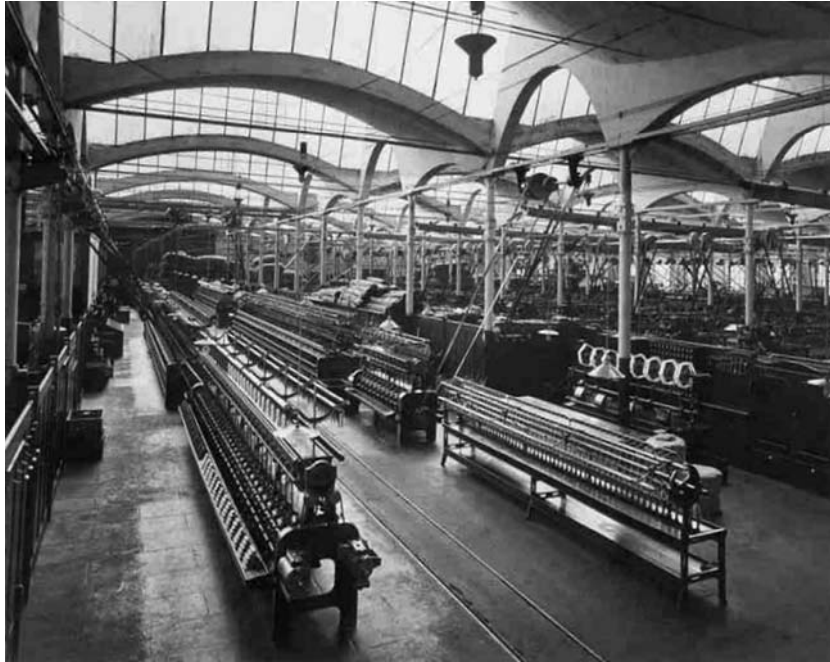
Figura 6.15: Vapor Aymerich, Amat y Jover. Vista del interior con la fábrica en funcionamiento, a la vista el inmenso espacio formado por una sucesión de bóvedas y lleno de telares (Huerta 2001, 274)
