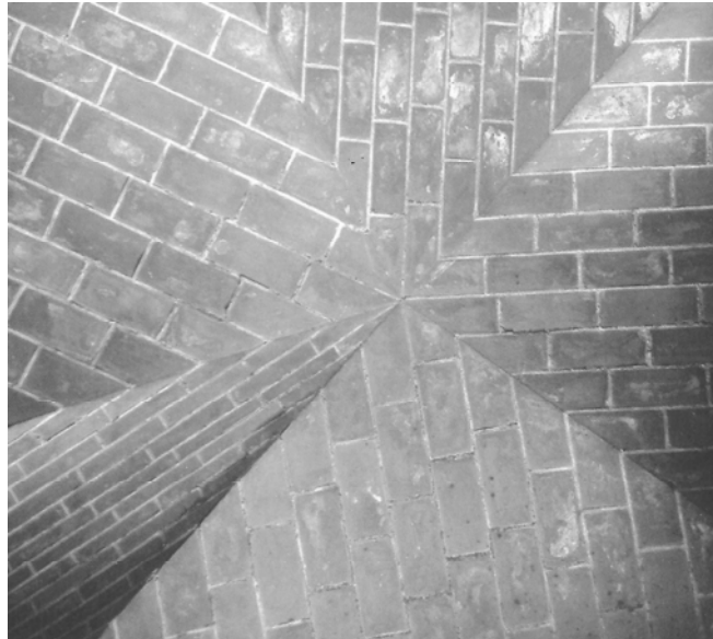
Figura 1.14. Capilla de la reina María en el convento de la Trinidad de Valencia. Uno de los primeros ejemplos de bóveda tabicada trabajando sin nervios de piedra. (Gómez Ferrer 2003, 143)
