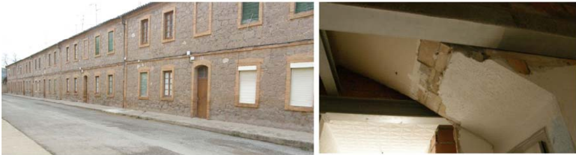
6.33. Colonia Marsal (Puig Reig, Barcelona). A la izquierda, vista exterior de las hileras de viviendas. Los arcos sobre puertas y ventanas son tabicados. A la derecha, detalle de una escalera tabicada. Imágenes tomadas en enero de 2013.
