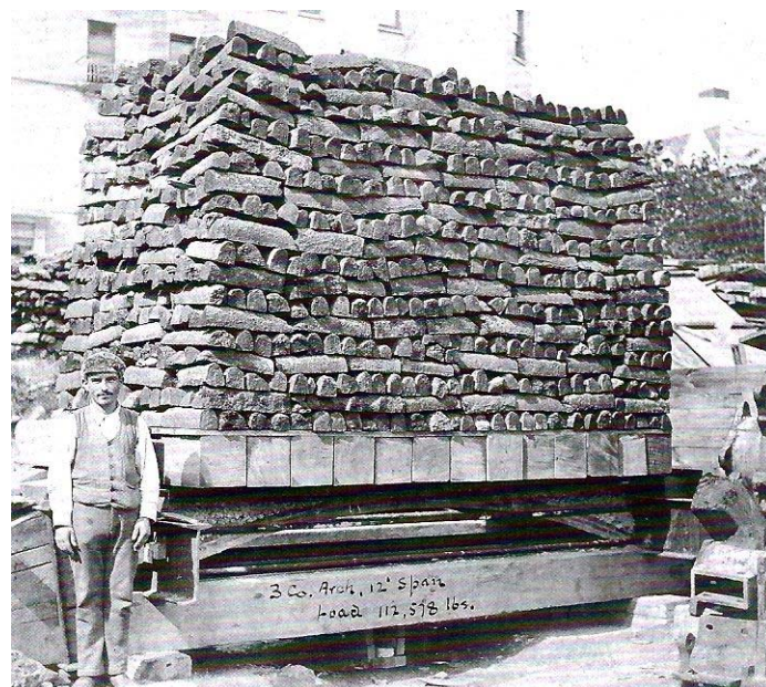
Figura 8.37: Otra bóveda, esta de 12 pies (3,66 m) con una gran carga: 112578 lbs., unos 510,35 kN. No está fechada. (Archivo Guastavino/Collins. U. Columbia).
