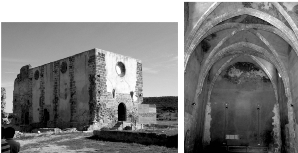
Figura 1.15: Cartuja de Valldescrist, en Altura (Castellón). A la izquierda, exterior de la capilla de San Martín (Serra y Miquel 2009, 69). A la derecha, interior: las bóvedas tienen plementería tabicada entre nervios de piedra (Serra y Miquel 2009, 70)
