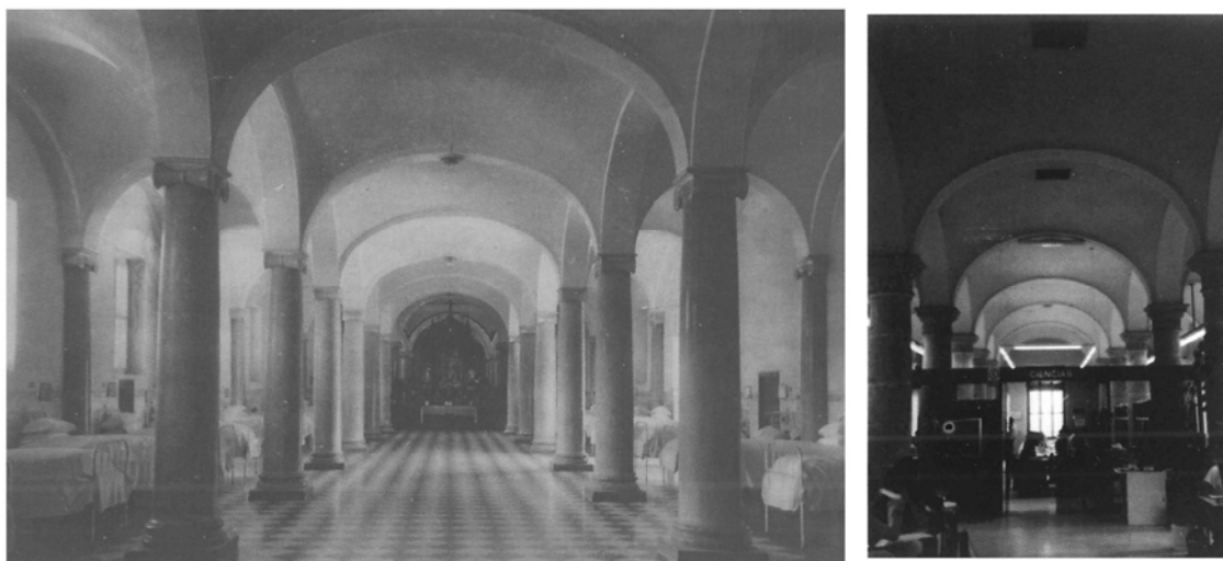
Figura 1.19. Bóvedas baídas renacentistas en el Hospital General de Valencia. A la izquierda, pabellón de enfermería, construido a partir de 1588 y actualmente desaparecido (Gómez Ferrer 2003, 137). A la derecha, edificio actual, convertido en Biblioteca Municipal (Gómez Ferrer 2003, 136).
