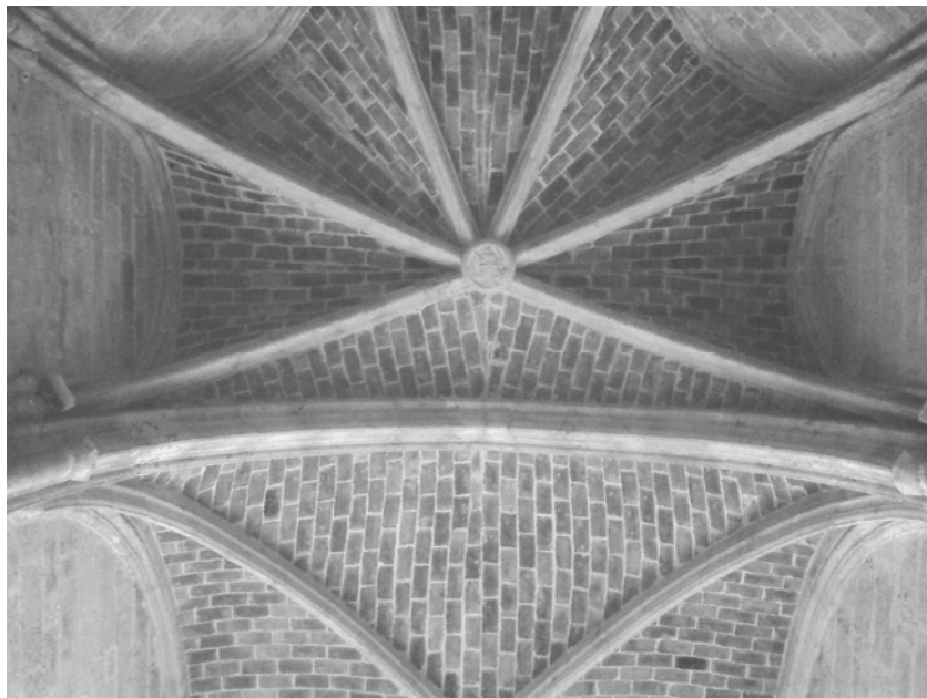
Figura 1.12: Bóvedas tabicadas en la Capilla de los Jofre, en el convento de Santo Domingo de Valencia (Gómez Ferrer 2003, 140)
