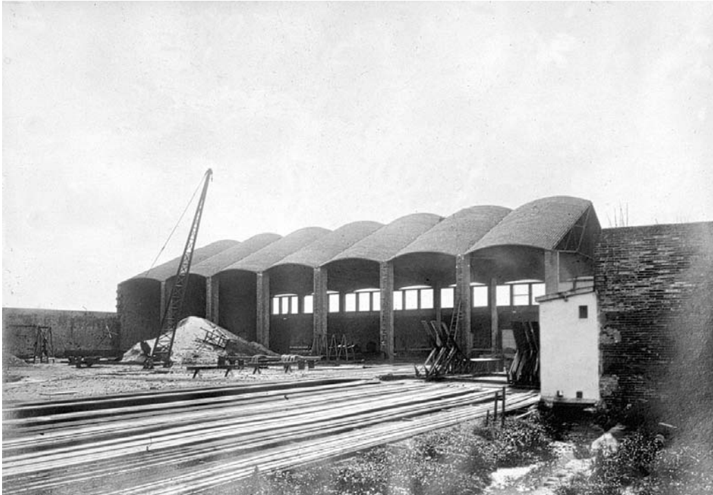
Figura 6.8: Cubierta de la nave de herrería de la empresa Torras y Construcciones (Martorell 1910, 128)
