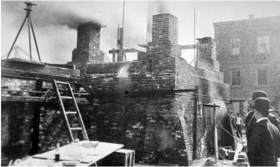
Figura 8.32: Paredes norte y este durante el fuego. 2 abril 1897. En el informe, photograph n° 1262 (Archivo Guastavino/Collins. U. Columbia).
