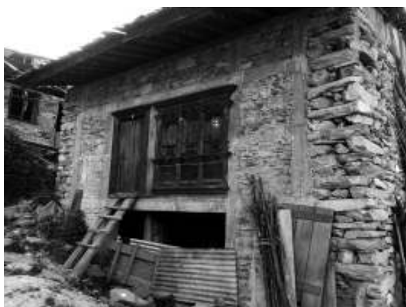
Figura 4 Foto de la tipología de vivienda reforzada (Autores)
