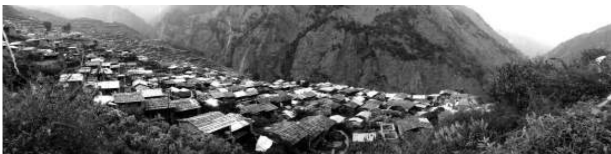
Figura 10 Foto del pueblo después del terremoto (Autores)
